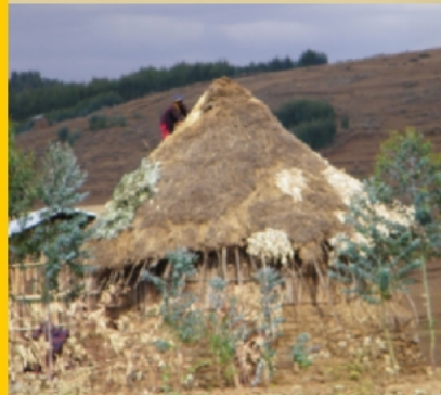
Ein Dachdecker beim Reparieren.
