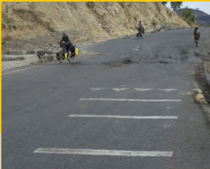
Die beeindruckende Straße hinunter zur Brücke.
