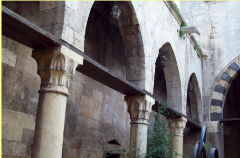
Im Bimaristan ist eine architektonische Besonderheit zu sehen. Man hat Holzbretter durch die tragenden Pfeiler laufen lassen und hoffte, so Erdstöße, die es in Damascus immer wieder gibt, abzufedern.
