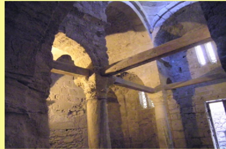
Die imposante Architektur der Burg. Deutlich wird hier, dass die Holzstreben nicht als Puffer bei Erdbebenbewegungen gedacht sind, wie in Syrien, sondern nur als Träger für z. B. Zwischendecken oder Lampen.
