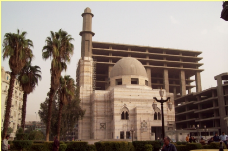
Eine Moschee im Bau, (Betongussverfahren) und dahinter ein Hochhausneubau (im Betongussverfahren)
