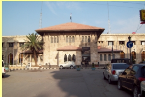
Der Bahnhof von Aleppo von außen...
